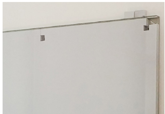
Ansicht der Vorderseite mit herausgetrennten Basotect-Quadern für die Aufhängung und den Verbinder
